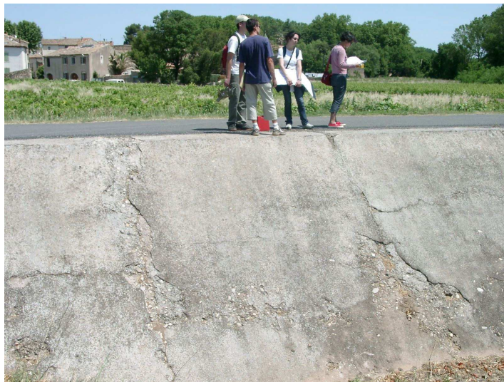
Figure 11.20. Talus côté cours d'eau revêtu d'un perré en béton incliné
