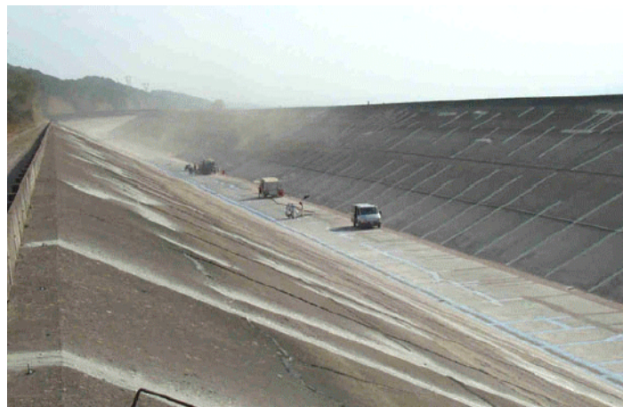
Figure 2.6. Digues du canal d'Oraison, période de travaux (Perez, 2004)
