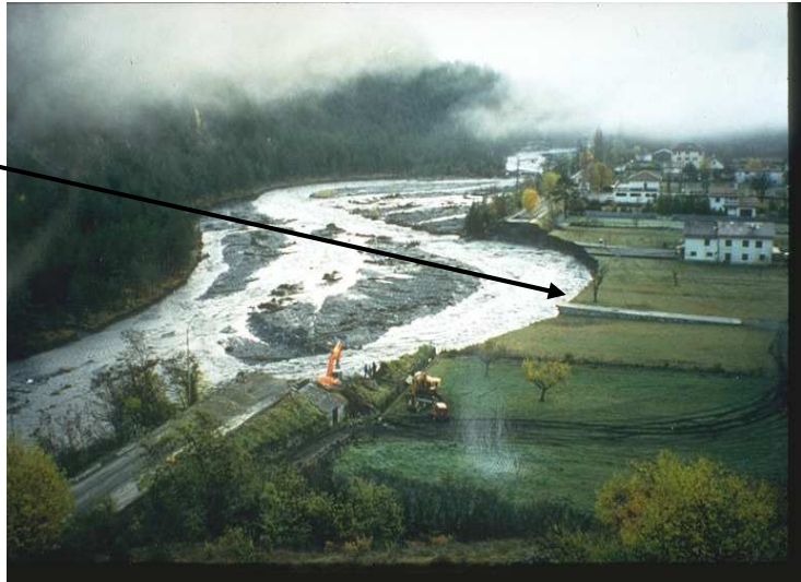
Figure 5.8. Rupture par érosion externe d'une digue du fleuve côtier Var
