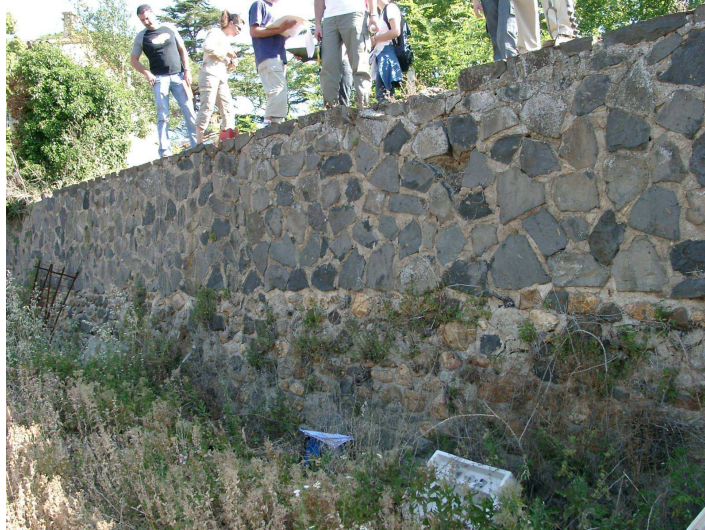
Figure 11.21. Structure côté cours d'eau formée d'un mur en maçonnerie
