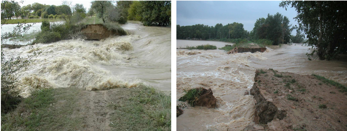
Figure 5.3. Cas de rupture par surverse sur le Vidourle (Gard)
