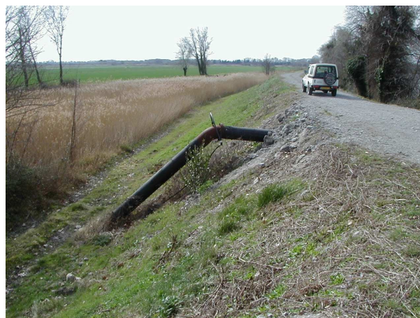
Figure 2.16. Ouvrage singulier dans la digue : une conduite
