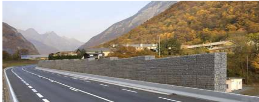
Figure 1.11. Mur antibruit à base de gabions (Livet et Gavet, France).
