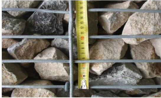
Figure 3.1. Vue détaillée des cailloux constituant le mur antibruit en gabions.
