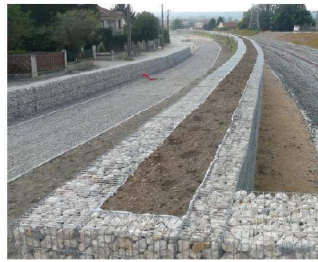
Figure 3.35. Gabions antibruit de faible hauteur ayant une âme en terre [138].
