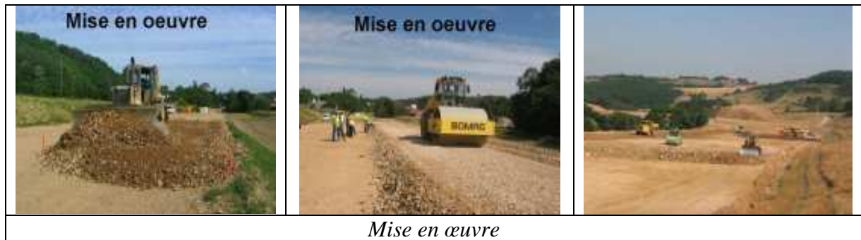
Figure 41 : Travaux de terrassements
