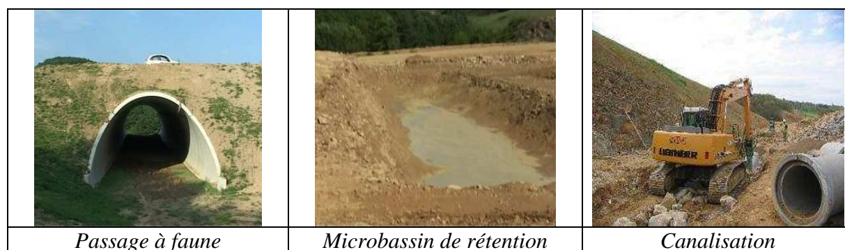
Figure 40 : Exemples de travaux de construction d'ouvrages d'art
