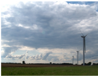
(a) Photographie d'éoliennes, Longeau Percey (52)
