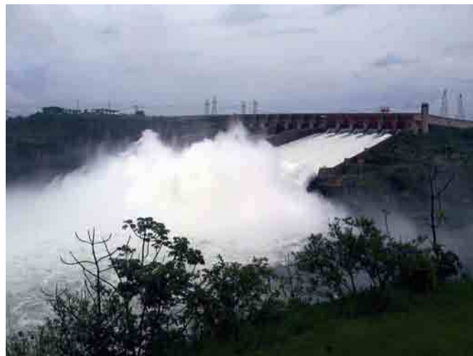
Déversoir de crue du barrage d'Itaipu
