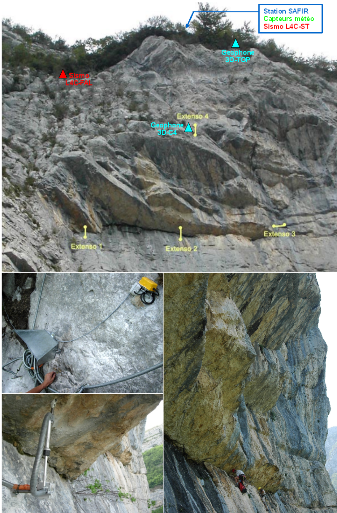
Figure 69 : Instrumentation des Grands Goulets : vue générale du dispositif (haut), mise en place des extensomètres sous le surplomb de la masse C2 (bas à droite), extensomètres et capteur vibration (bas à gauche)
