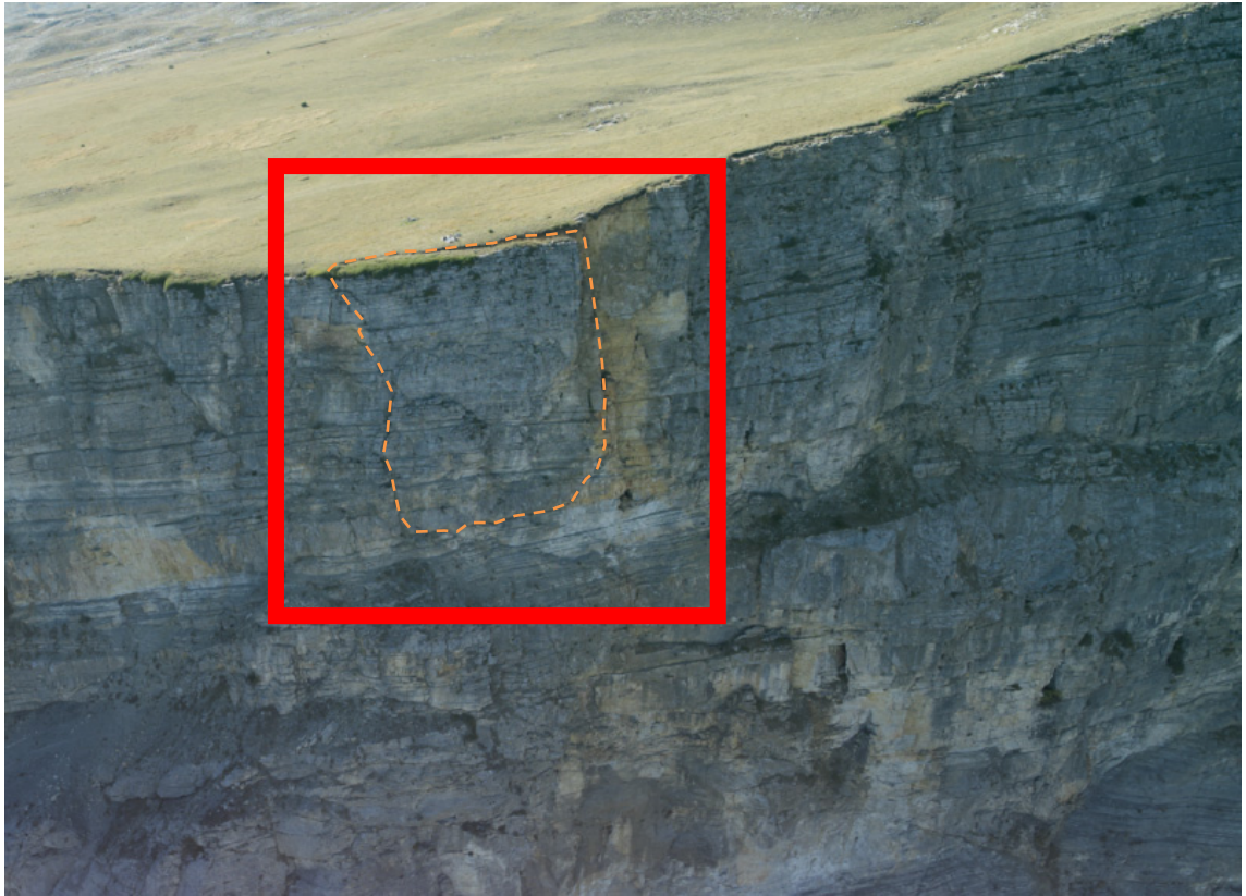
Figure 43 : Photographie de l'échelle avant l'éboulement (Photo LGIT)
