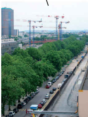
Voie de dégagement de l'entrepôt le long du boulevard Macdonald.
