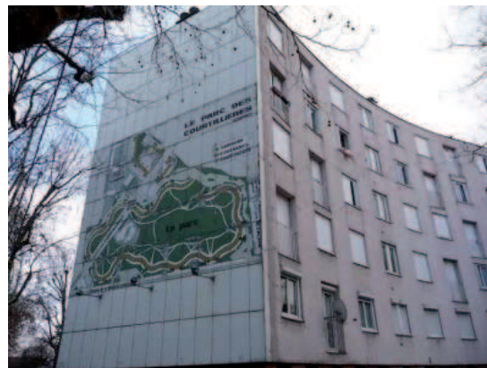
En 2006, le projet de réhabilitation du Serpentin est validé par l'ANRU. Source : www.batiactu.com/ , consulté le 28 octobre 2011.
