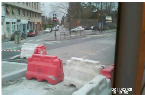
Figure 37 : Travaux publics qui attirent les regards de notre utilisateur
