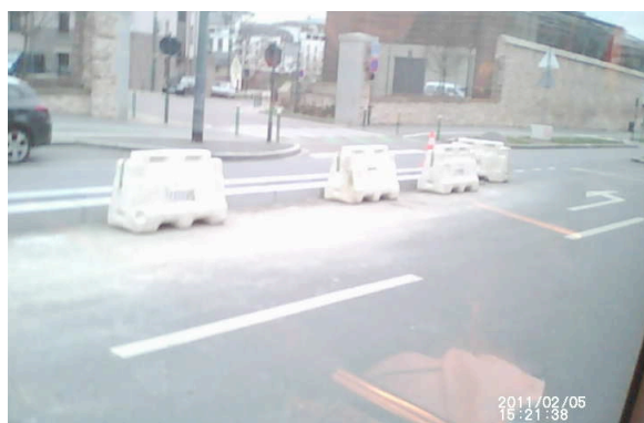
Figure 38 : Regard vers d'autres travaux publics
