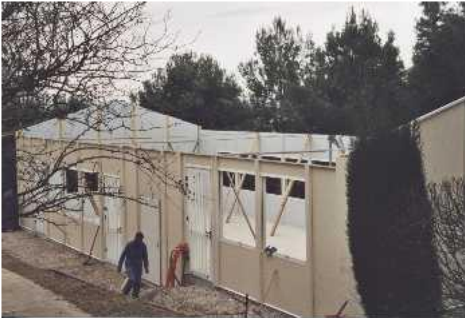
Photo n° 8 : Les nouveaux bâtiments en construction à Perpignan (2001)
