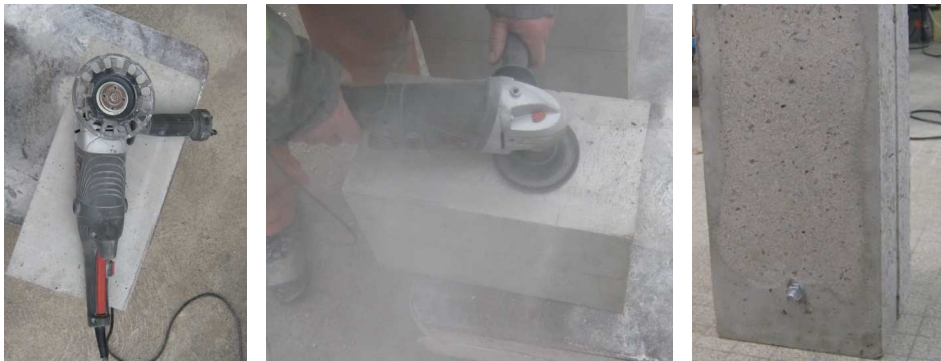
Figure III-19 Ponçage de surface du béton à l'aide d'une disqueuse.
