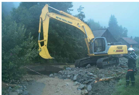
FIG. 1.3: Curage du lit du torrent pour maintenir la capacité d'écoulement dès la fin de la matinée
