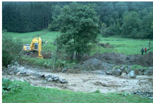
FIG. 1.4: Création de digues à partir des matériaux chariés pour canaliser le lit en fin d'après-midi
