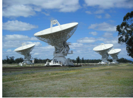
FIGURE 2.2 – L'interféromètre ATCA composé de 6 antennes de 22 m de diamètre (Narrabri, Australie).
