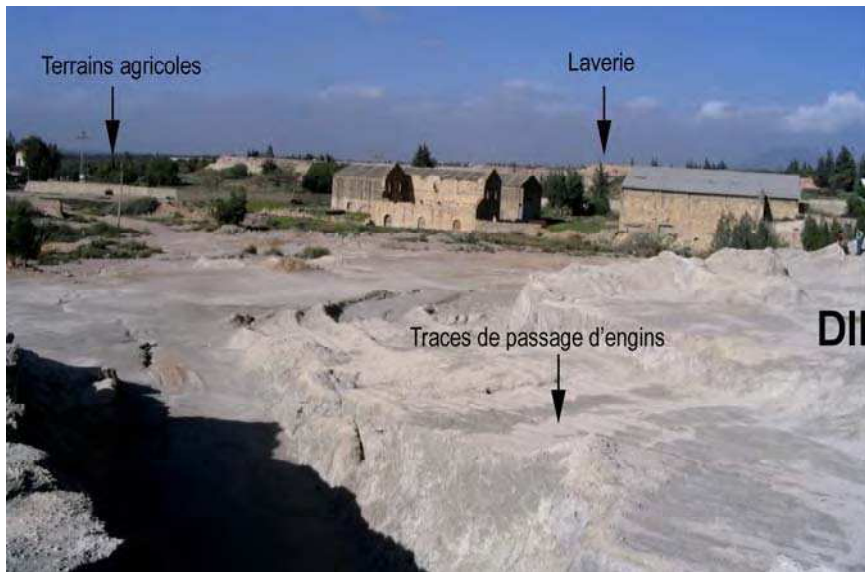
Figure V.4 : Aspect de la surface du terril DII après l'enlèvement d'importante quantité de déchets par les engins
