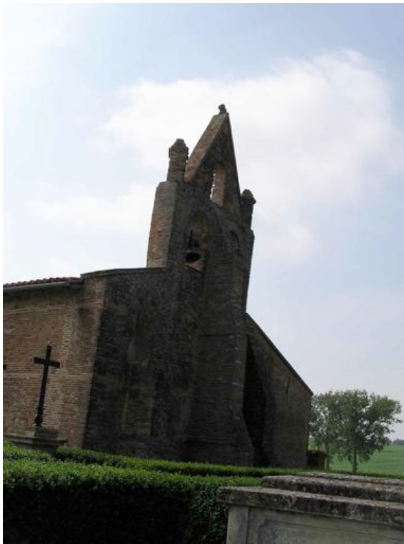
Illustration 3. – Le clocher-mur de l'église de Sainte-Colombe de Baziège
