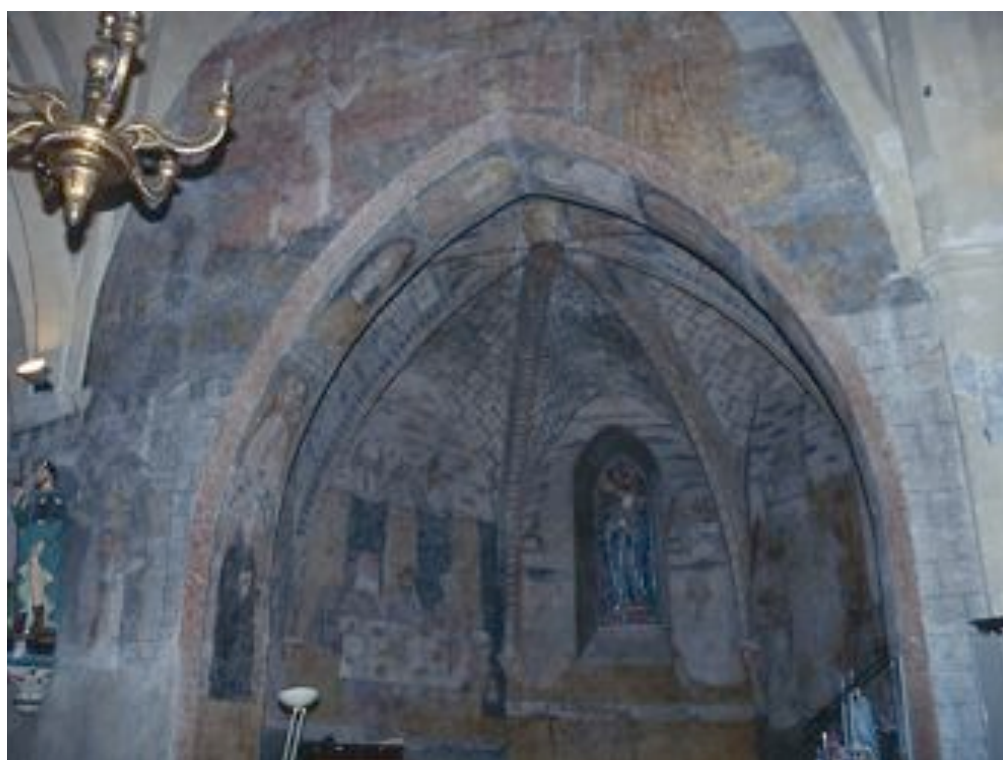
Illustration 49. – Une chapelle latérale de l'église paroissiale de Belberaud
