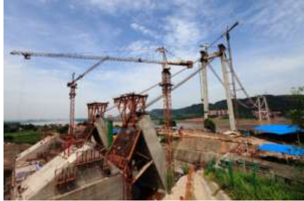
Le pont de Nanxi en cours de construction à Yibin (Sichuan, photo prise en 2011)
