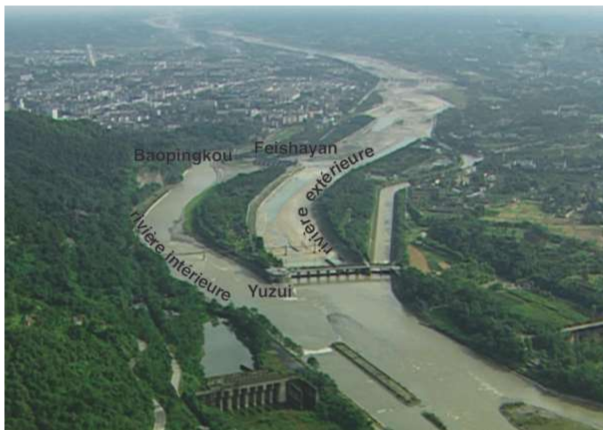
Photo 9 : Vue à vol d'oiseau de l'ouvrage hydraulique de Dujiangyan
