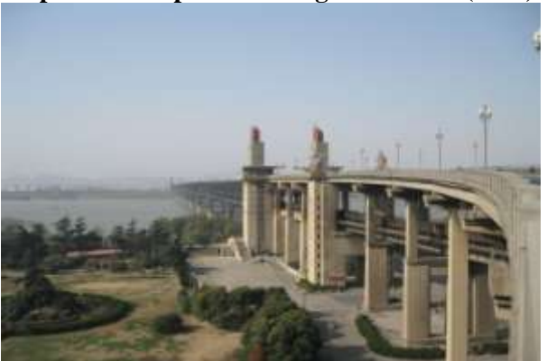
Le plus ancien pont du Yangzi à Nankin (1957)
