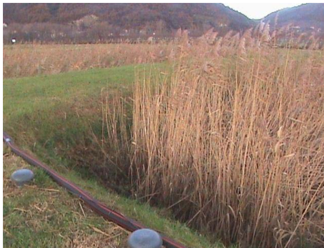
Figure 11 : filtre planté de roseaux à écoulement vertical avec un système d'aération (France)
