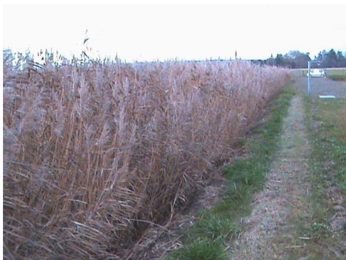
Figure 12 : filtre planté de roseaux à écoulement horizontal (France)
