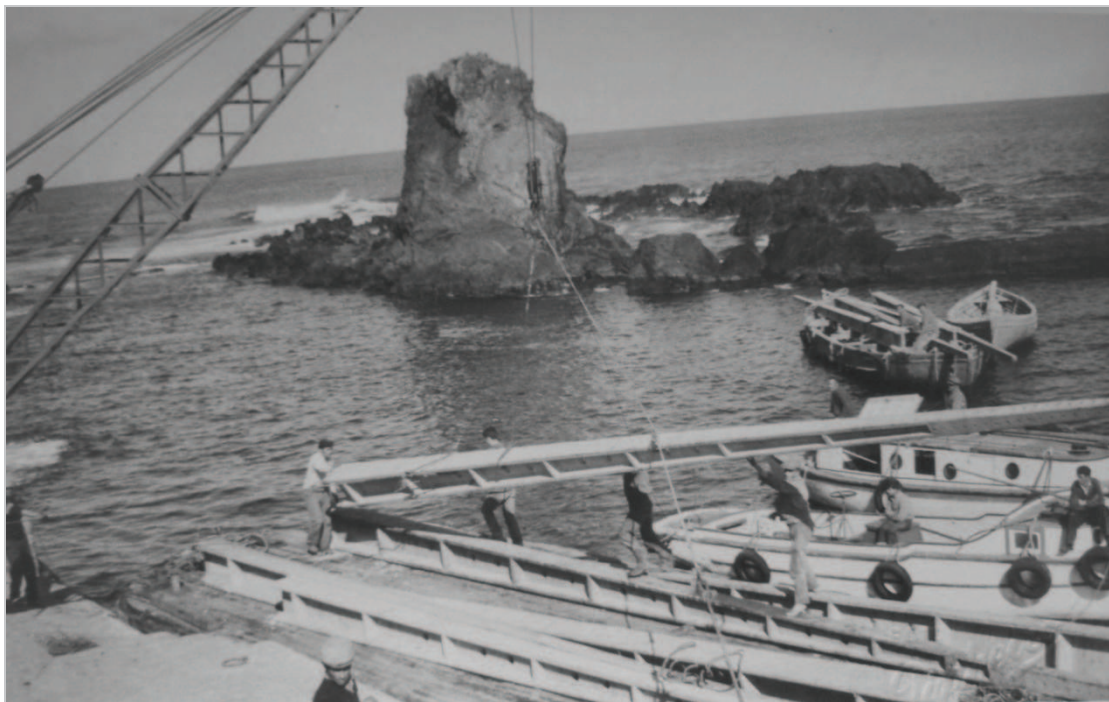
Figure 52 Débarquement au port de Santa Cruz das Flores des premiers pylônes électriques apportés par la frégate de l'armée française entre 1965 et 1969 - Collection photographique de Roberto Fraga
