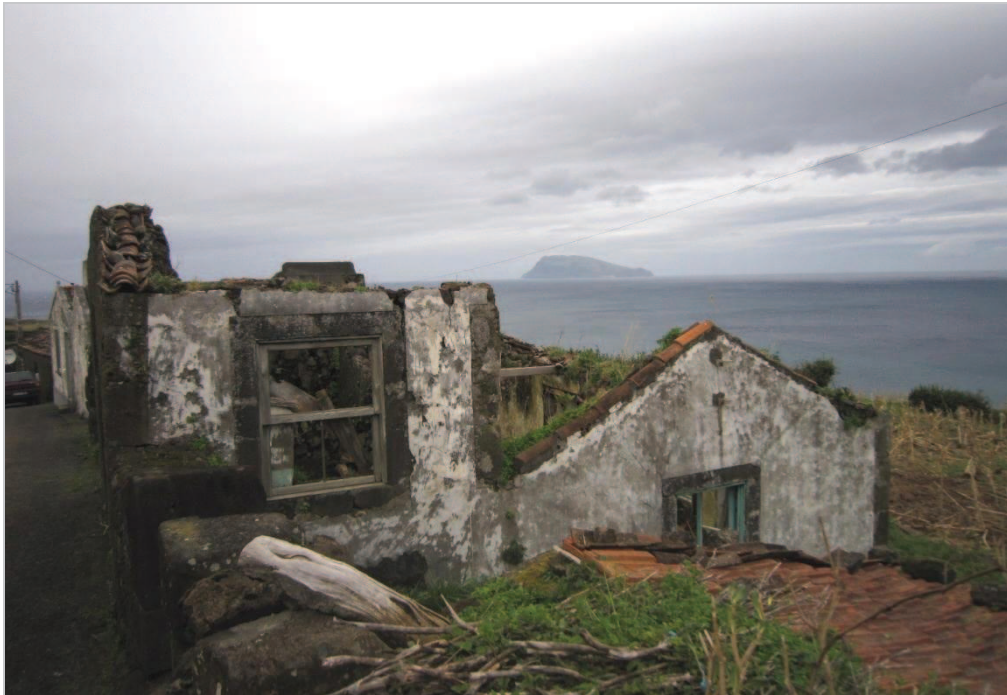
Figure 30 Une énième maison abandonnée, dans le village de Ponta Delgada au nord de Flores (Açores) - janvier 2010. On aperçoit l'île voisine de Corvo au large.
