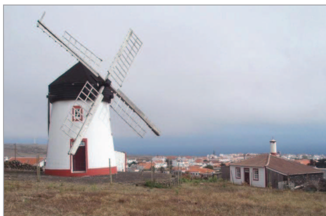
Figure 96 Moulin récemment rénové, Ginjal, Vila do Porto, Santa Maria
