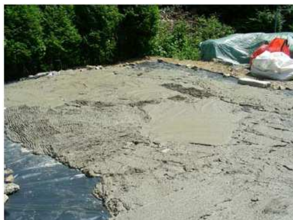
Figure II-2 : Photo prise lors du séchage de la gâchée
