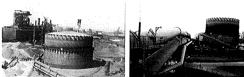
figure 2-13 : photographies du gazomètre. Par rapport à la visée, le tuyau passe derrière la cuve et la route est vue avant la cuve. Entre ces deux images, on peut observer un changement de hauteur de la partie supérieure située au-dessus de la passerelle, signifiant que le toit est mobile.
