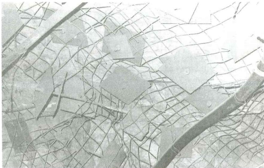
Photo n° 8 : Défauts dans la pose des boulons. Boulon mal enfoncé.
