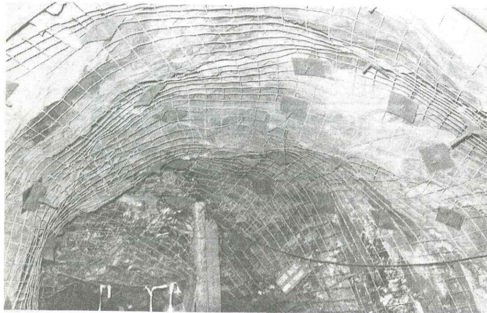
Photo n° 4 : Défauts dans la pose des boulons. Plaques bombées mises à l'inverse.
