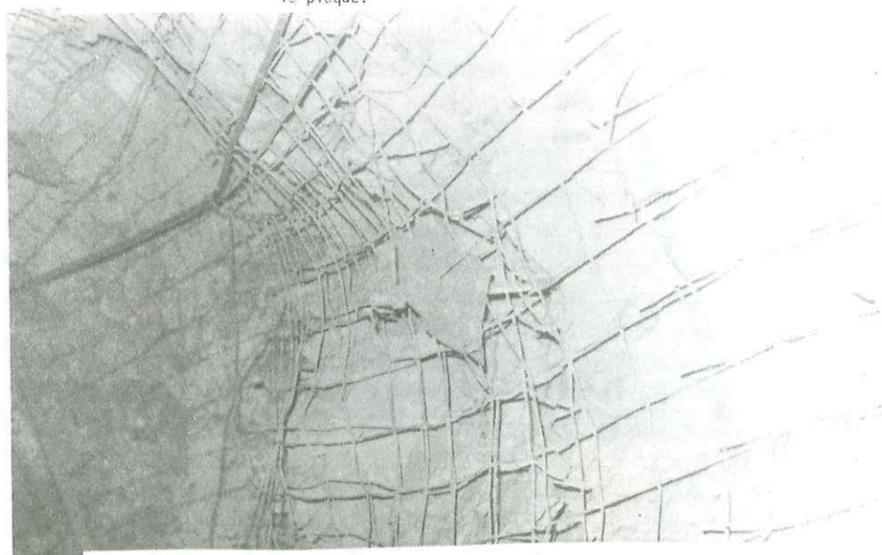
Photo n° 10 : Défauts dans la pose des boulons. Plaques mal serrées.
