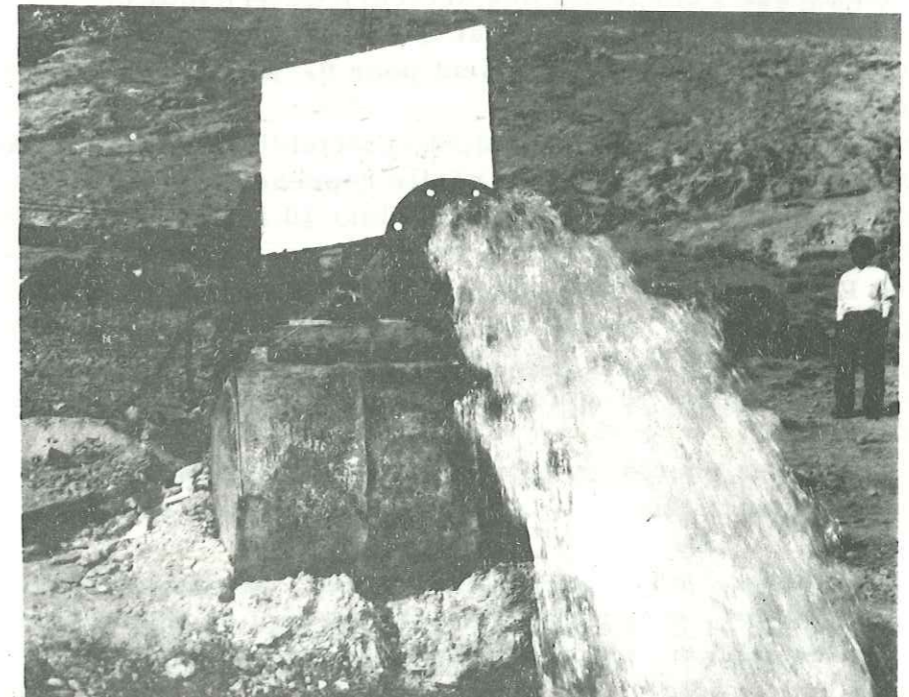
Photo n° 24 - Essai de pompage sur le puits n° 5, près du village de Saadi -
