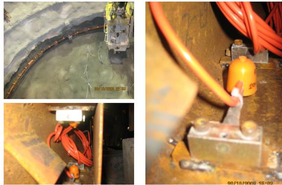
Figure 5.8 Pose du cintre instrumenté et jauges extensométriques
