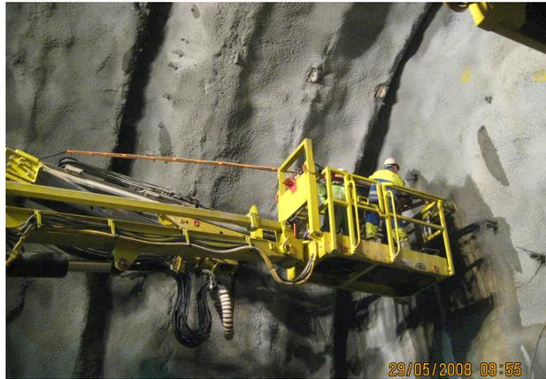
Figure 3.9 Enfilage d'un boulon en fibre de verre
