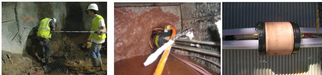
Figure 5.7 Extensomètres radiaux
