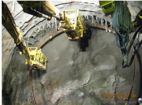
Figure 3.11 Pose et réglage du cintre
