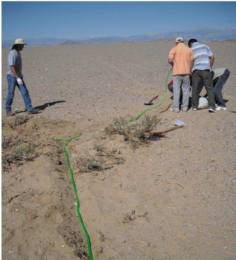
FIGURE 3.26 – Enterrement du réseau de filtrage de la station C3.
