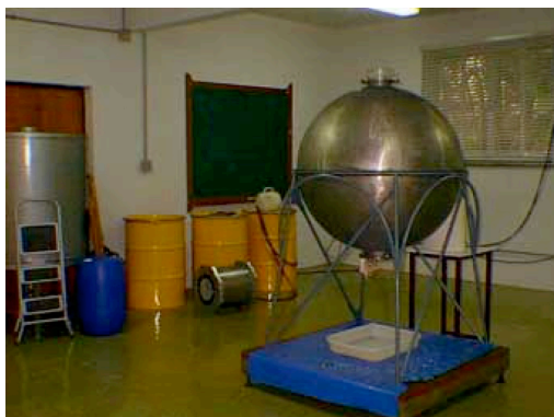
Figure 2.11.: Vue de l'installation au L.N.M.R.I.
