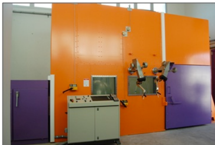
Figure 2.6.: Vue extérieure de la casemate actuelle de mesure neutronique du LNE-LNHB
