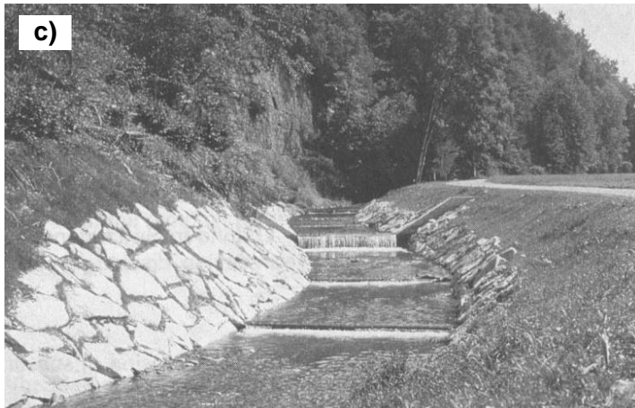
Figure 82 : principaux moyens de lutte contre les incisions a) barrage (check dam) sur le torrent de Straubach (Jaeggi et Zarn 1999) b) rampe de blocs sur la rivière Ticino (Jaeggi et Zarn 1999) c) série de seuils artificiels sur la rivière Enziwigger (Jaeggi et Zarn 1999) d) pavage artificiel sur la rivière Moesa (Jaeggi et Zarn 1999) e) concept de restauration de la Russian River : lit à trois niveaux (Shields et al. 1999) f) introduction de graviers sur le Rhin en aval du barrage d'Iffezheim (Kondolf 1997)
