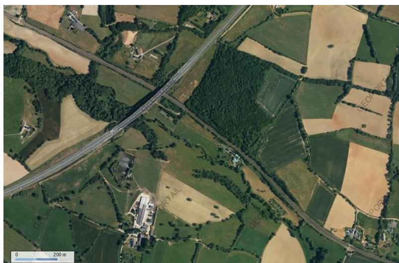
Figure 3.7 : vue aérienne de la SLT. (source : geoportail ® )
