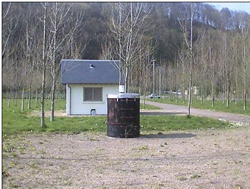
Photo I. 5 – Local technique et forage de Saint Maurice d'Etelan. Emplacement du pluviomètre.
