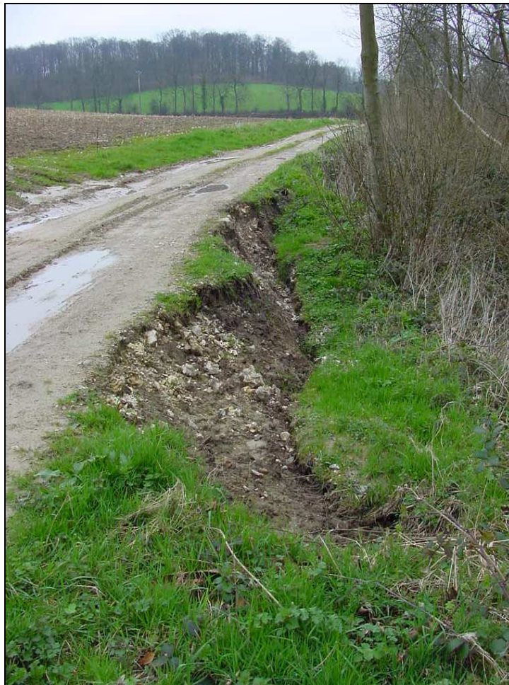
Photo III. 1 – Effondrement des berges du Bébec suite à une période de précipitations intenses.
