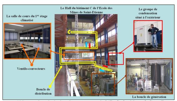
Figure 135 La boucle de distribution au sein de L'Ecole des Mines de Saint Etienne
