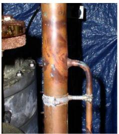
Figure 147 Observation de la déformation de la tuyauterie
