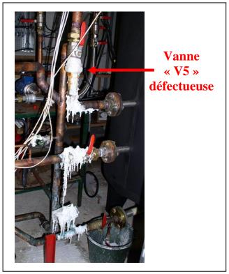
Figure 153 Exemple d'une fuite de solution de TBAB
