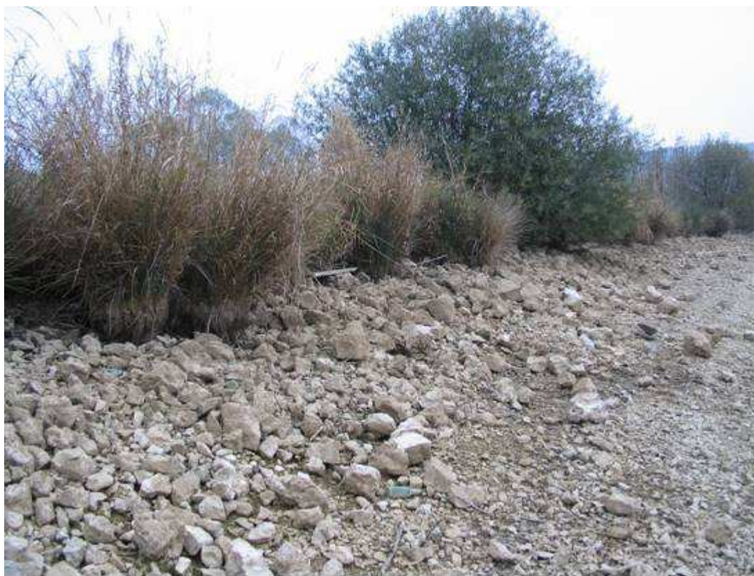
Etat Rip Rap amont
