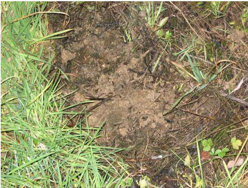
Figure 41 : Présence de zones humides sur le remblai aval
