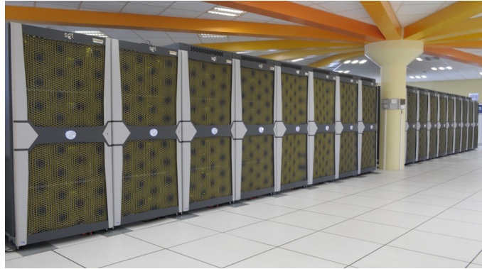
FIGURE B.1 – Le cluster SGI Altix ICE 8200, dit JADE, est un supercalculateur scalaire parallèle d'une puissance crête de 267 Tflop/s. Ce cluster comprend 23040 cœurs répartis sur 2880 nœuds, chacun disposant de 2 processeurs Intel Quad-Core E5472 ou X5560. Chaque nœud dispose de 30 Go de mémoire utile. Le refroidissement est assuré par un système haut rendement air/eau.
