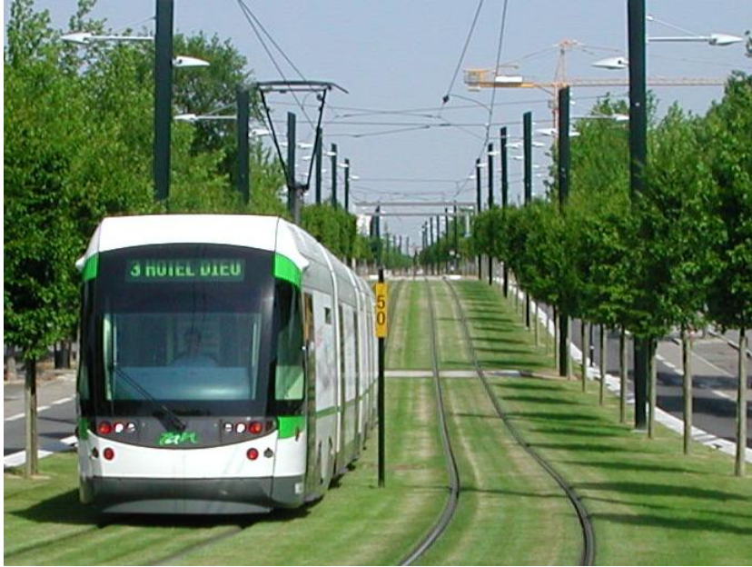
FIGURE A.5: Revêtement de surface naturel (herbe) sur une voie de tramway à Nantes
