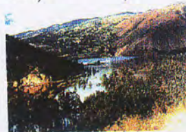
Photo N°10 Vue de la retenue avant rupture du barrage 04/93
