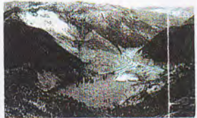
Photo N°3 Glissement principal de la Josefina vu depuis l'Est 10/93
