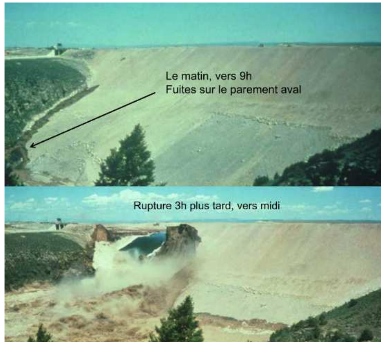
FIGURE 1.2.5: Rupture du barrage de Teton suite à la formation d'un renard
