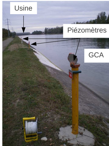
(a) Piézomètres en crête de digue à l'extrémité haute du parement amont
