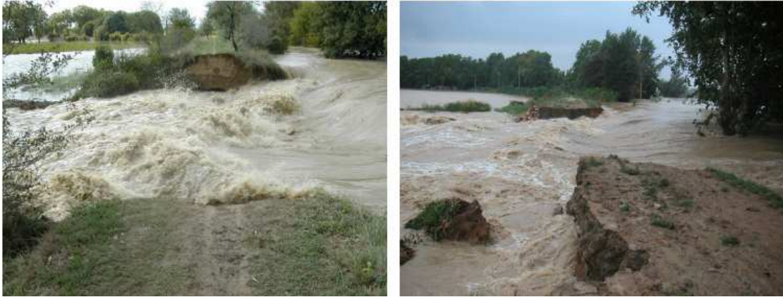
FIGURE 1.2.2: Cas de rupture par surverse sur le Vidourle (Gard), extrait de Serre (2005)
