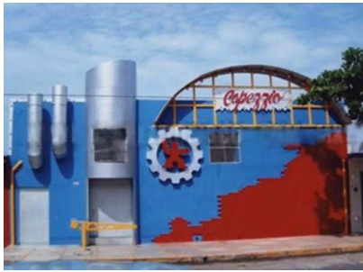
Figure 22 : Façade de Capezzio Disco
