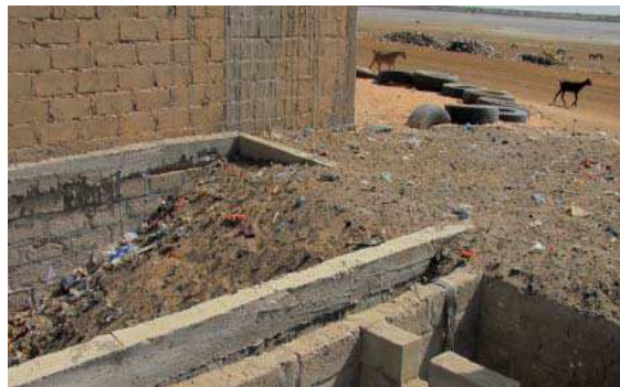
Photos 48-49: Terrains et fondation entourés par un mur et remblayés par des déchets à Pikine.
