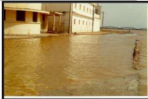
Photo 56: Inondation de 1999 : Pointe sud de l'île.
