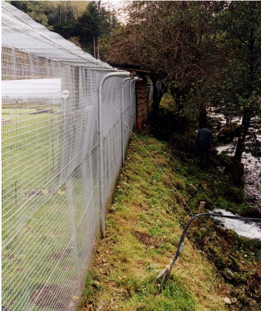
Figure I.13. Grillage de protection de l'ensemble du périmètre de la pisciculture de Bugeat (19). La hauteur du grillage est de 2m, avec un retour de 30 cm électrifié. L'ensemble est serti dans un muret de béton s'enfonçant à 50 cm sous terre. Photo C.LEMARCHAND.
