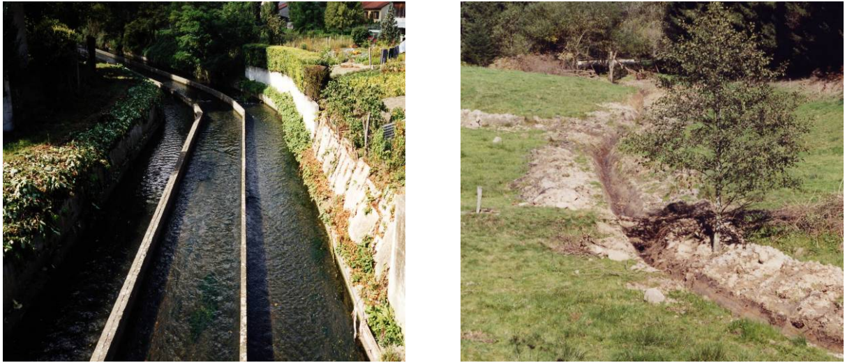
Figure I.3. Canalisation, recalibrage et suppression de la végétation rivulaire sur un cours d'eau (à gauche), drainage de zones humides (à droite) banalisent le biotope et provoquent la régression ou la disparition des proies de la loutre. Photos C. Lemarchand.
