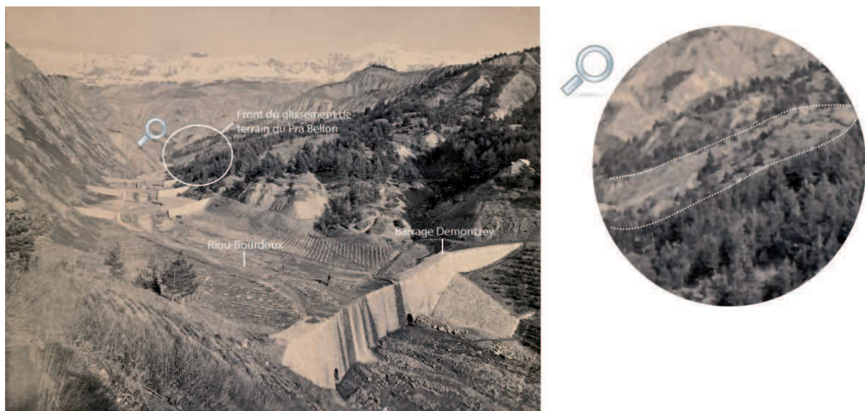
Figure 105. Barrage de Demontzey en 1891. En rive gauche du torrent du Riou Bourdoux, il est possible d'apercevoir le front du glissement de terrain du Pra Bellon. Le détail montre une surface remaniée et totalement dénudée.
