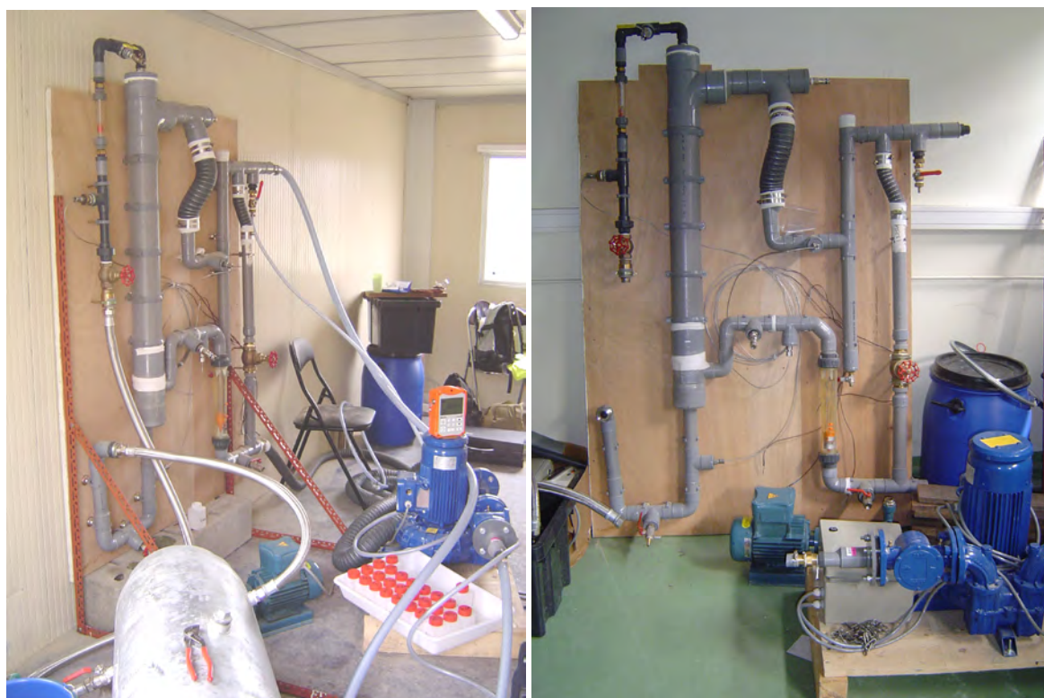
Figure 99 : Photographies du pilote de traitement gaz-liquide
