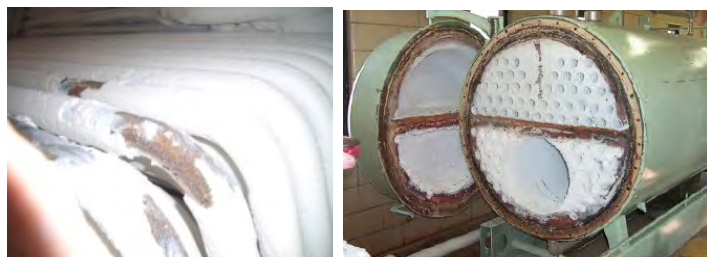
Figure 9 : Dépôts dus aux composés siliciés sur les brûleurs
