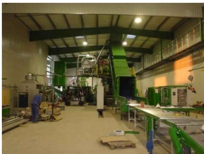
Figure 48: Convoyeur avec les stations de dépollution
