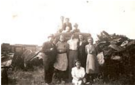
Figure 20 : La famille Fournier sur le chantier
