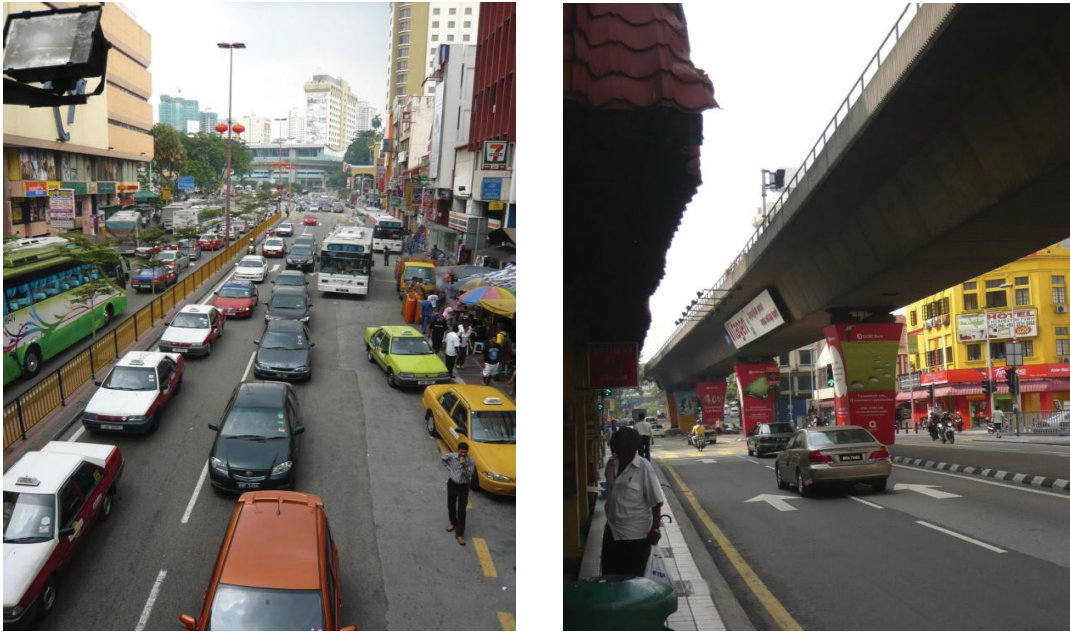
Illustration 33 : Congestion et dégradation de la vieille ville
