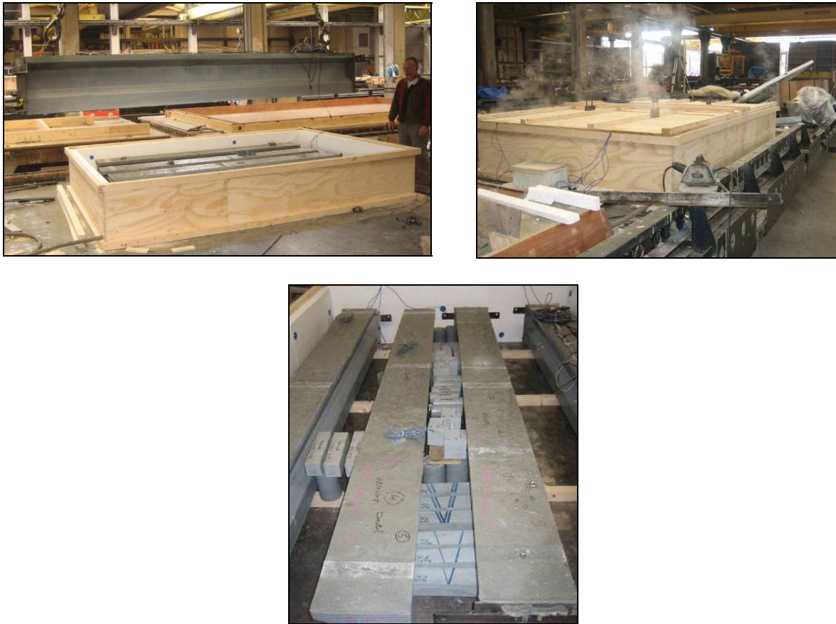
Figure 3-6 Dispositif pour le traitement thermique des poutres en BFUP-F
