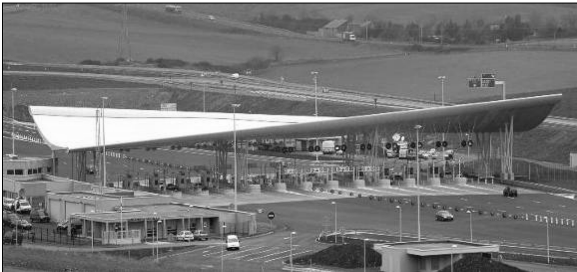
Figure 1-8 Barrière de péage du Viaduc de Millau en France
