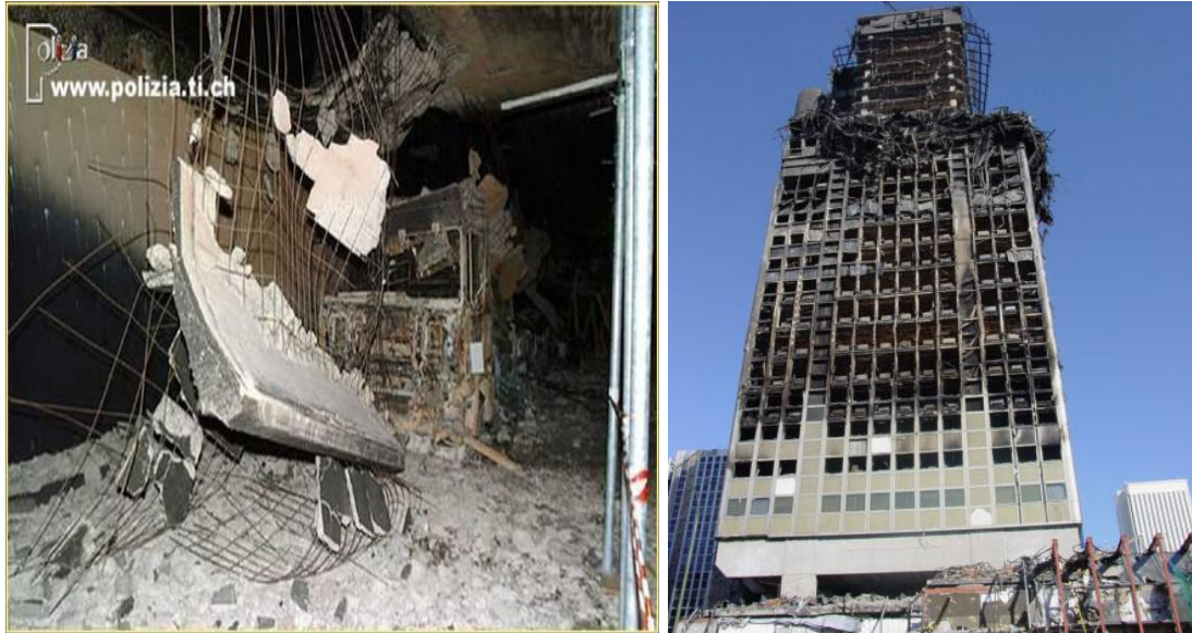
Figure 5.2. Photos des dégâts causés par l'incendie : A gauche, le tunnel du Saint Gotthard (Suisse) en 2001. A droite, la tour Windsor à Madrid en 2005 [MEN 10].
