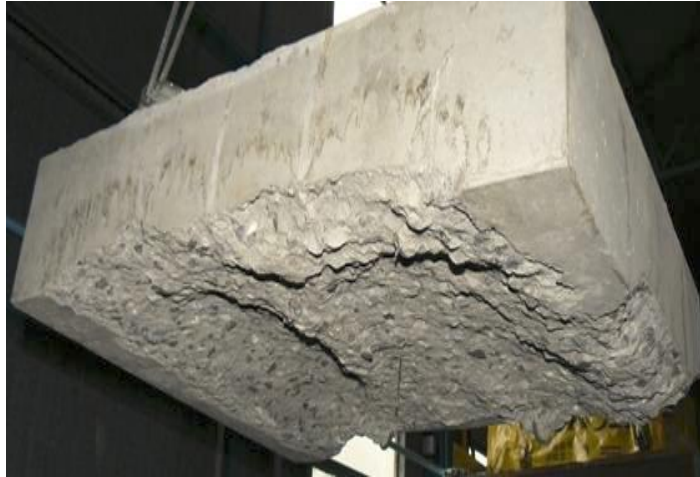
Figure 5.12. Photo d'une dalle après l'essai au feu (B60) chauffage lent [MIN 10]
