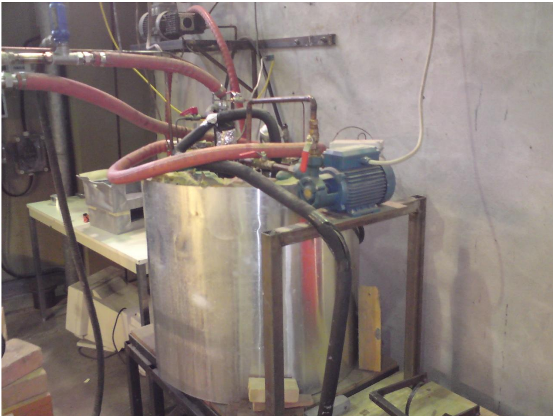
Figure 4.33. Vue de module de production de vapeur
