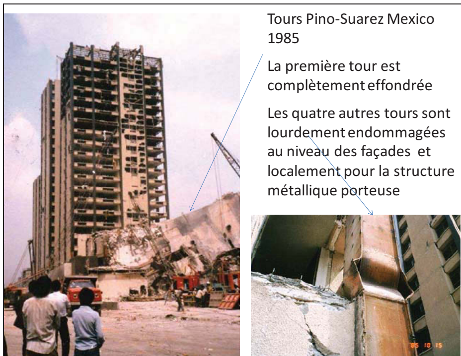
Figure 1.7 : Destructions d'immeubles dues à un séisme au Mexique 1985 [DAV 85b]
