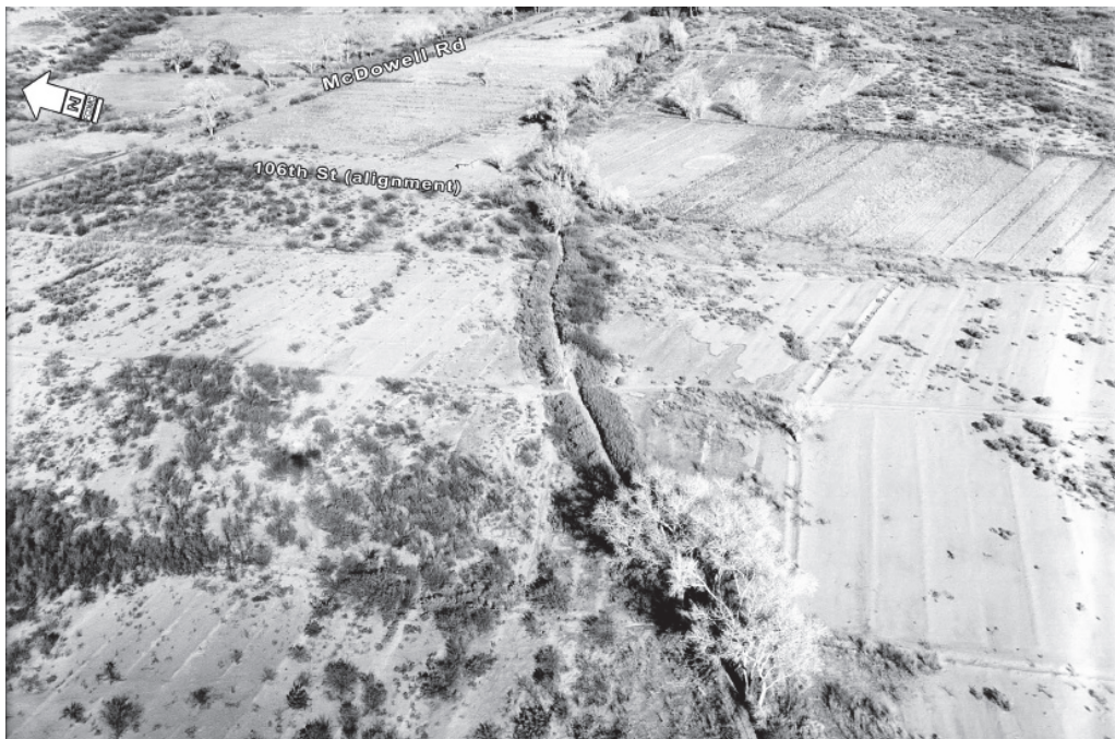
Fig. 52 : Vue de l'ouest d'un canal d'irrigation en terre en 1930. Intersection entre McDowell Road et 106th street. (SRP, 1930)
