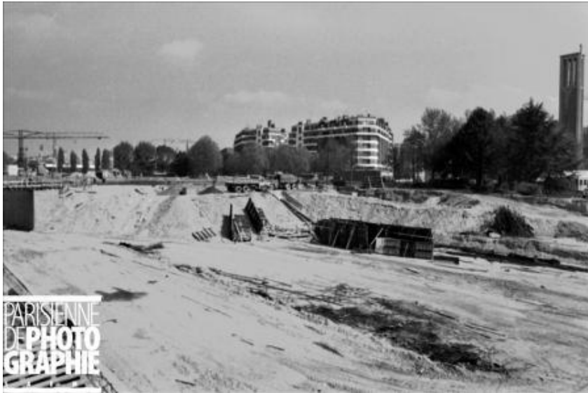
Photographie n° 4 - Paris, construction du boulevard périphérique, Porte de Saint-Cloud
