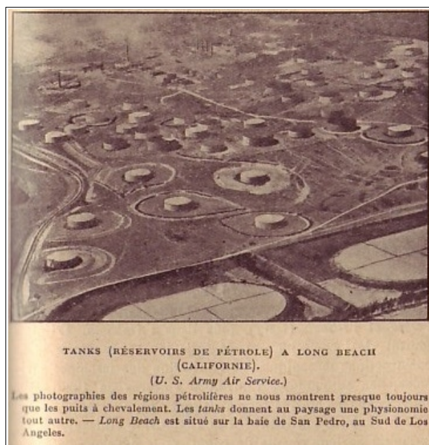
Figure 3 : « Tanks (réservoirs de pétrole) à Long Beach (Californie) 1044 » Une image de la modernité dans les années 1930 : des réservoirs de pétrole en Californie, dont la consommation est
