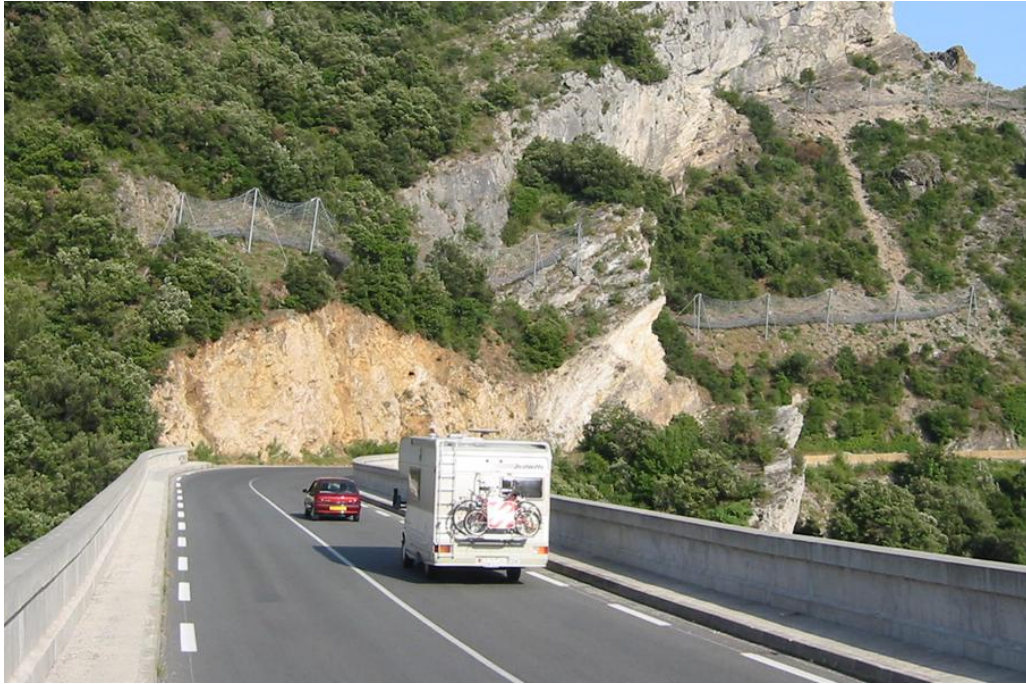
Figure I. 10 : Ecrans de filets pour la protection des routes (photos GTS)
