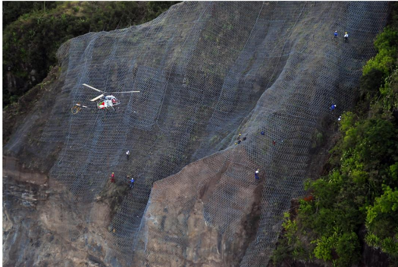
Figure I. 4 : Installation de filets plaqués par hélicoptage, photo GTS
