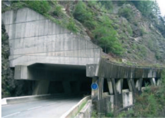
Figure I. 5 : Galerie pare-bloc de conception classique, [DEL 05]
