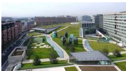
Photo 13 – Le Jardin sur le Toit (1).
