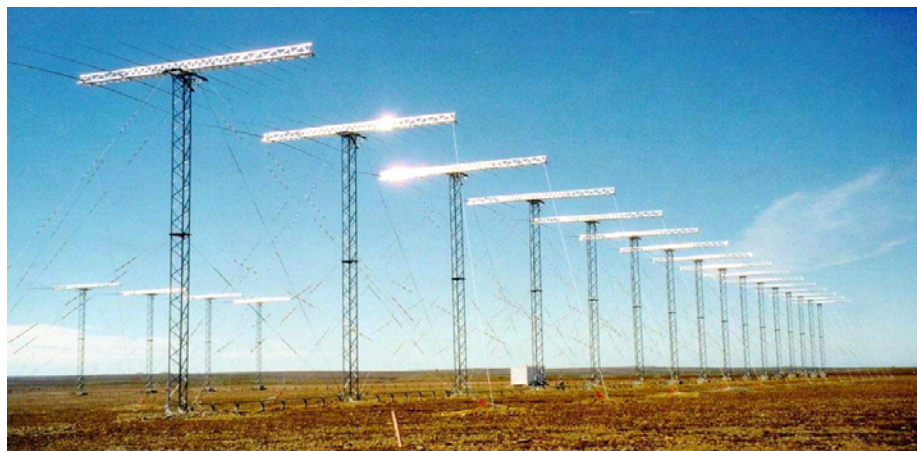
FIG. 1.8 – Vue générale du radar de Kerguelen, avec les 16 antennes qui constituent le réseau principal et, en arrière plan, les 4 antennes du réseau interférométrique.
