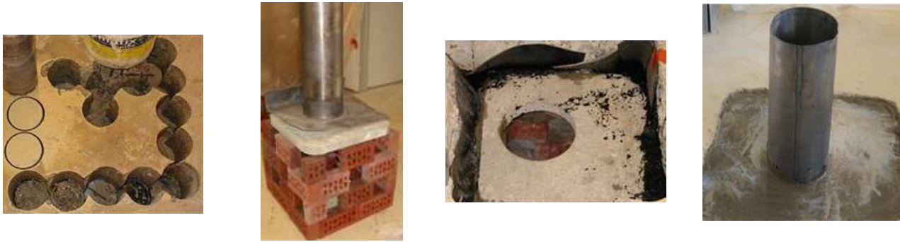
Figure 5.3 : Photos de mise en œuvre du puisard spécifique à l'extraction naturelle. Les photos de gauche à droite illustrent: percement de la dalle; conception du puisard; couverture du puisard et son étanchement et reconstitution du dallage.
