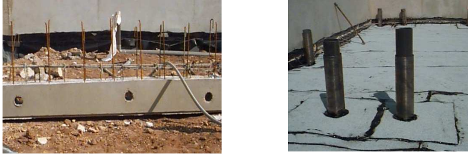
Figure 4.8 : Vue du longrine (à gauche) et étanchéité de la membrane au niveau des piquages et du mur (à droite).
