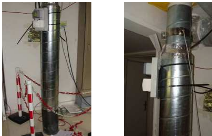
Figure 5.4 : Photos du conduit reliant le puisard à la cheminée
