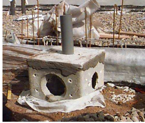
Figure 4.10 : mise en place d'un puisard.
