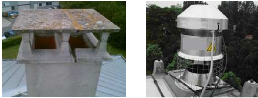
Figure 5.5 : Photos des extracteurs utilisés lors du suivi annuel: cape à l'italienne (à gauche) et extracteur stato-mécanique (à droite).
